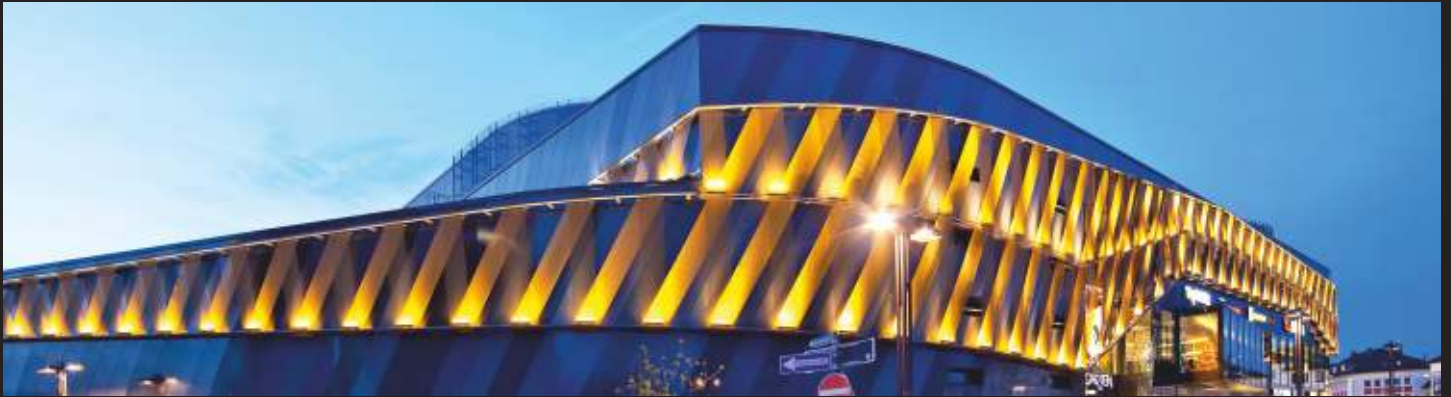
Hofgarten Solingen Shopping Centre / Solingen, Allemagne / L'effet de ruban d'or en grille tissée SATURN sur la façade extérieure. Mise en œuvre avec la sous-structure.
