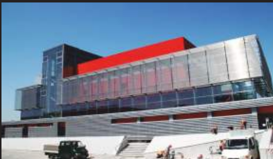
Salon de Kielce / Kielce, Pologne / 9 applications de mailles et de grilles architecturales. Une superficie totale de 6000 m 2 .
